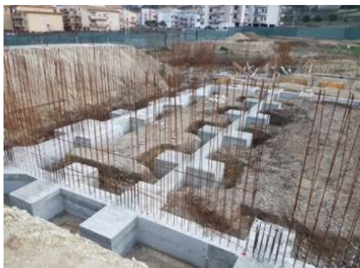
Foto 3 – Strutture di fondazione Corpo A
