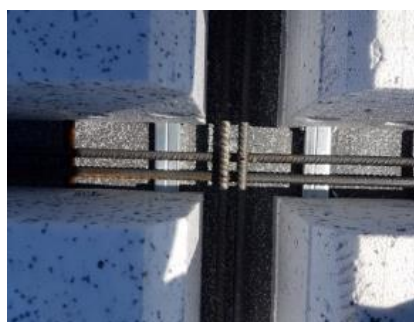
Foto 9 – Particolare Solaio Cube in EPS
