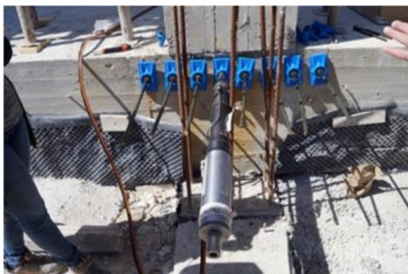
Foto 8 – Fase di tiro dei cavi
