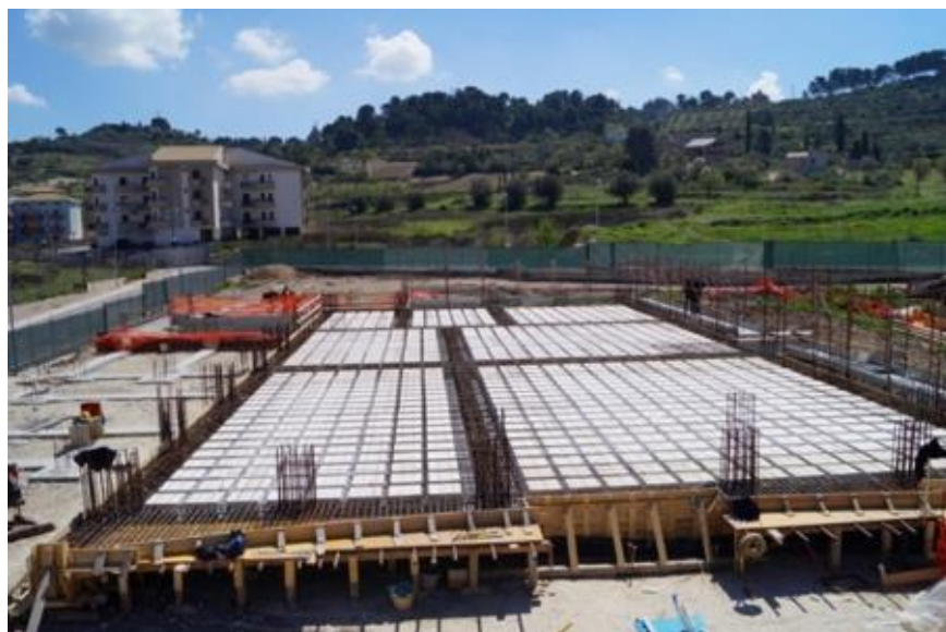
Foto 2 – Solaio PlastBau CUBE
