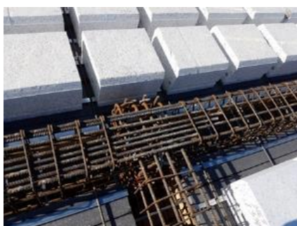
Foto 9 – Particolare Solaio Cube in EPS
