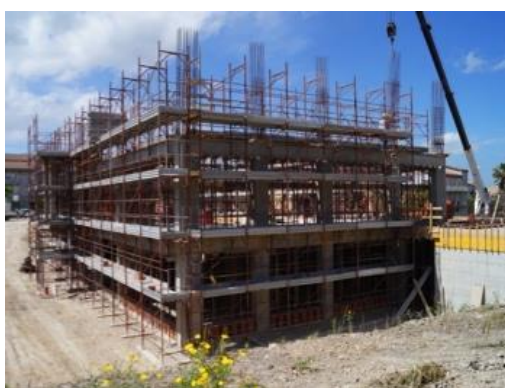
Foto 5 – Struttura intelaia in fase di costruzione
