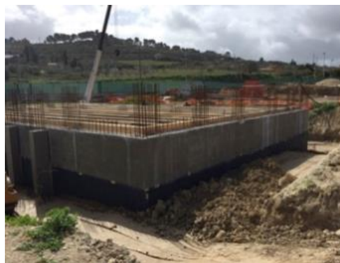
Foto 4 – Muro del piano seminterrato
