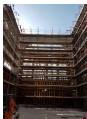
Foto 6 – Portale con setti antisismici
